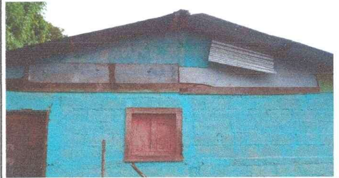
Foto 2: Sustitución de techo
