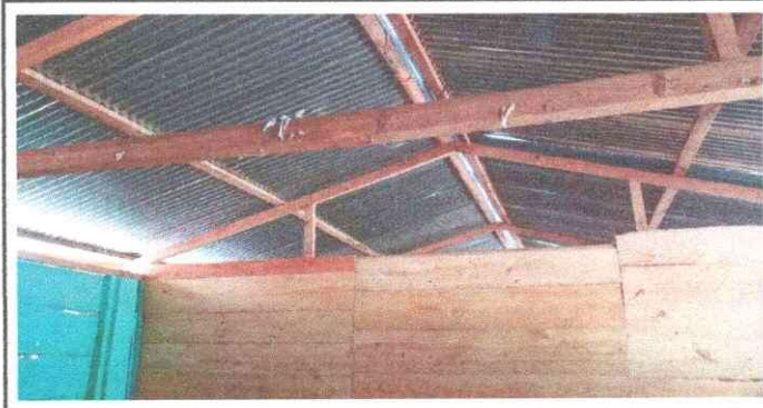
Foto 4: Sustitución de mojinete
